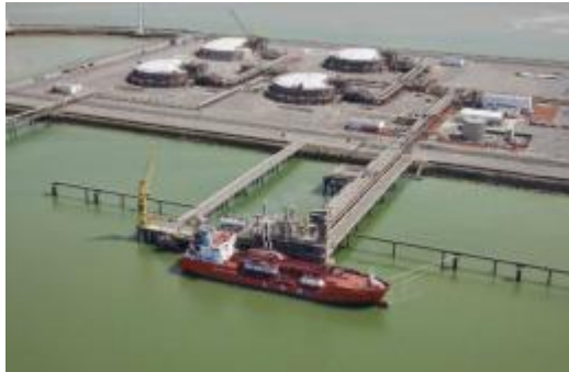
Operación de suministro de GNL desde una Planta de Regasificación
